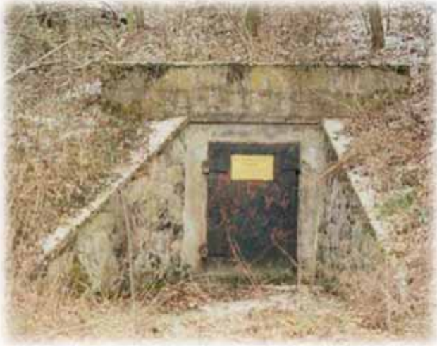
< Das Mundloch des Stollens 2019
